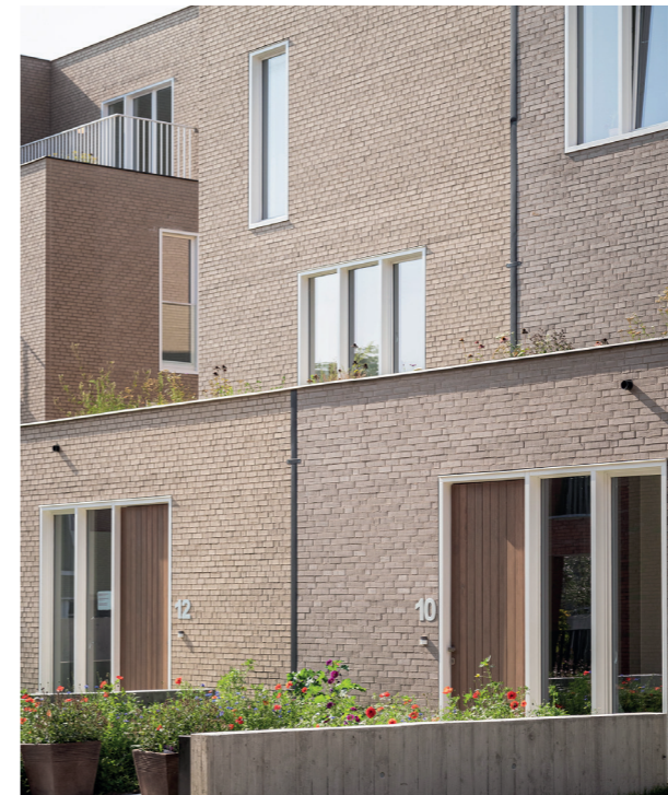
Achterwijkende gevel Watt Site Gent ©Caan architecten
