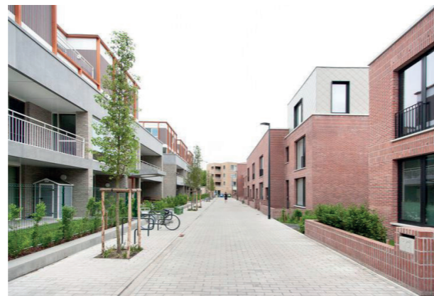
Midden Boechout, Komaan! architecten_BULK Architecten
