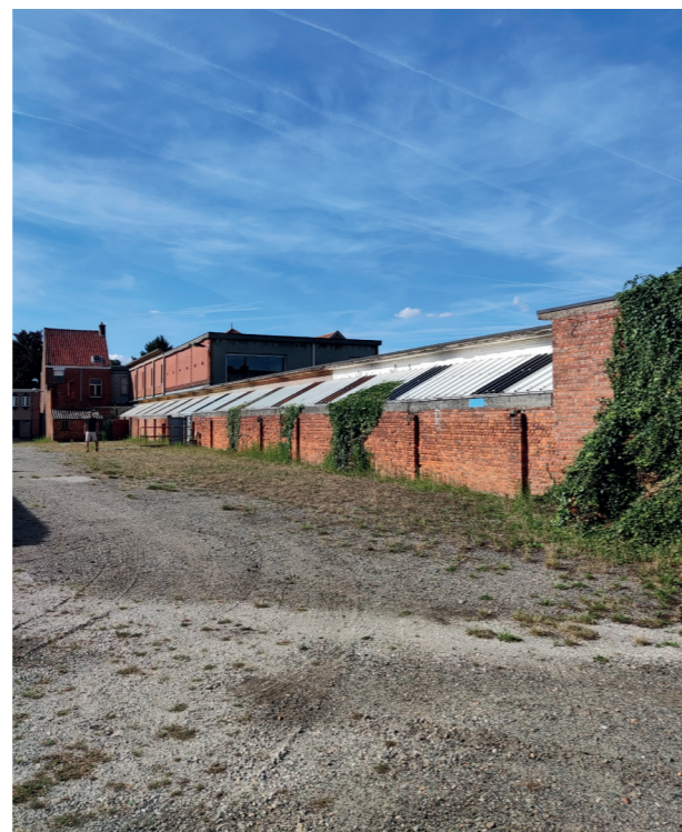
verharding en energetisch oneficiënte bebouwing
