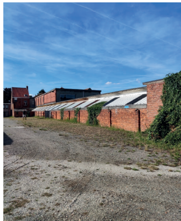
verharding en energetisch oneficiënte bebouwing
