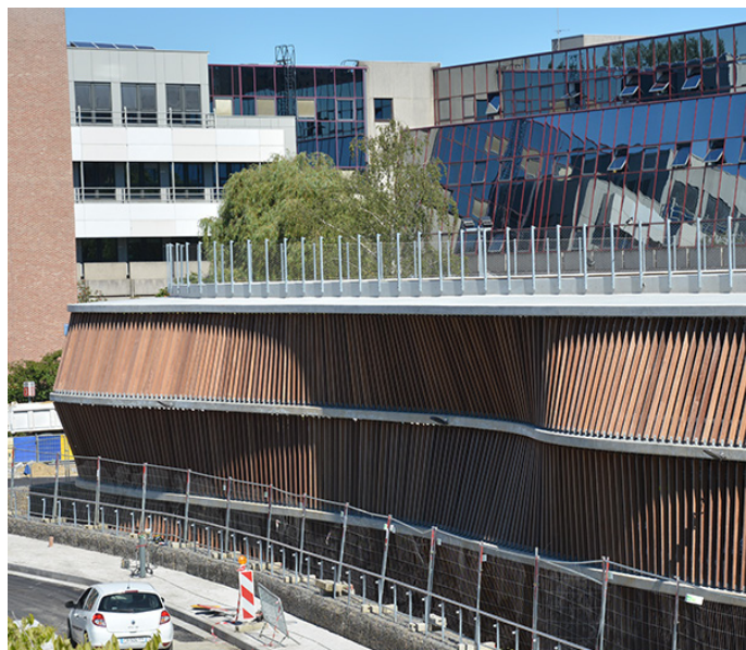
Parkeergebouw CU Saint-Luc, Namen, Modulo Architecten
