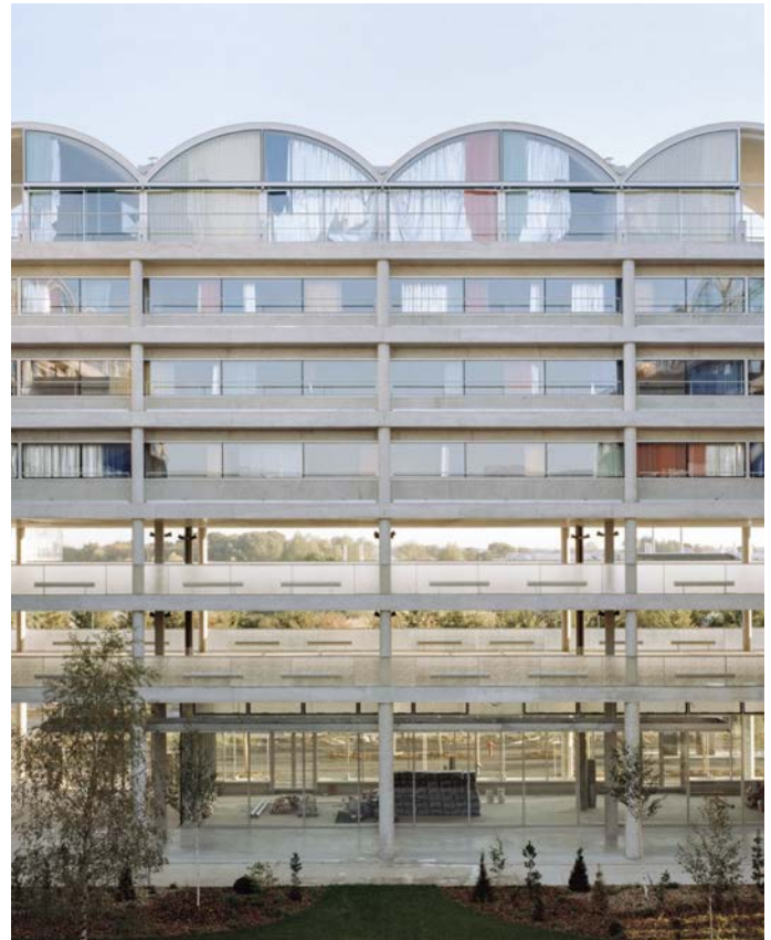
transformeerbaar parkeergebouw, Plateau de Saclay, Bruther & Baukunst
